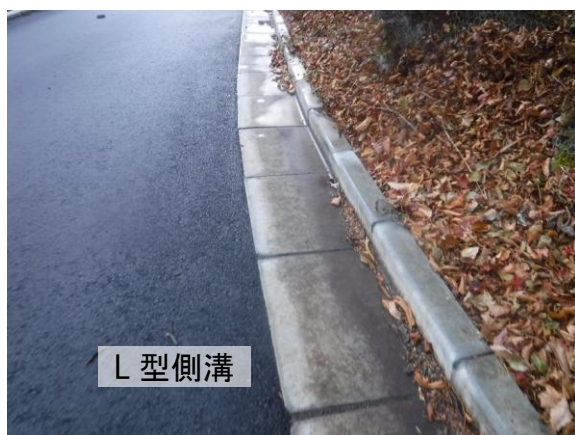
図 2 4 林道東俣線の舗装等工事の実施状況例
