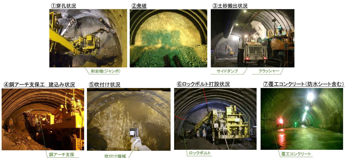
図 8 NATMの標準的な施工手順
