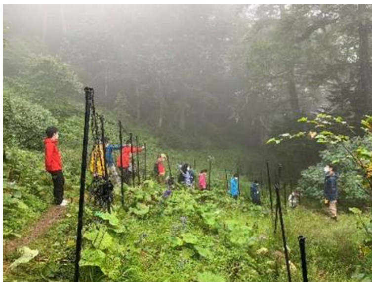
写真 5 獣害防止柵の設置例（千枚小屋付近）
