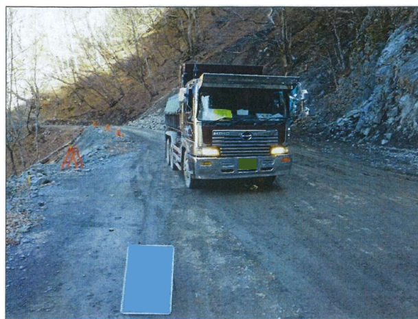
写真 3 ダンプトラックによる運搬イメージ
