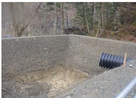
写真 4 沈砂池の例
