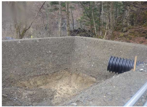
写真 4 沈砂池の例
