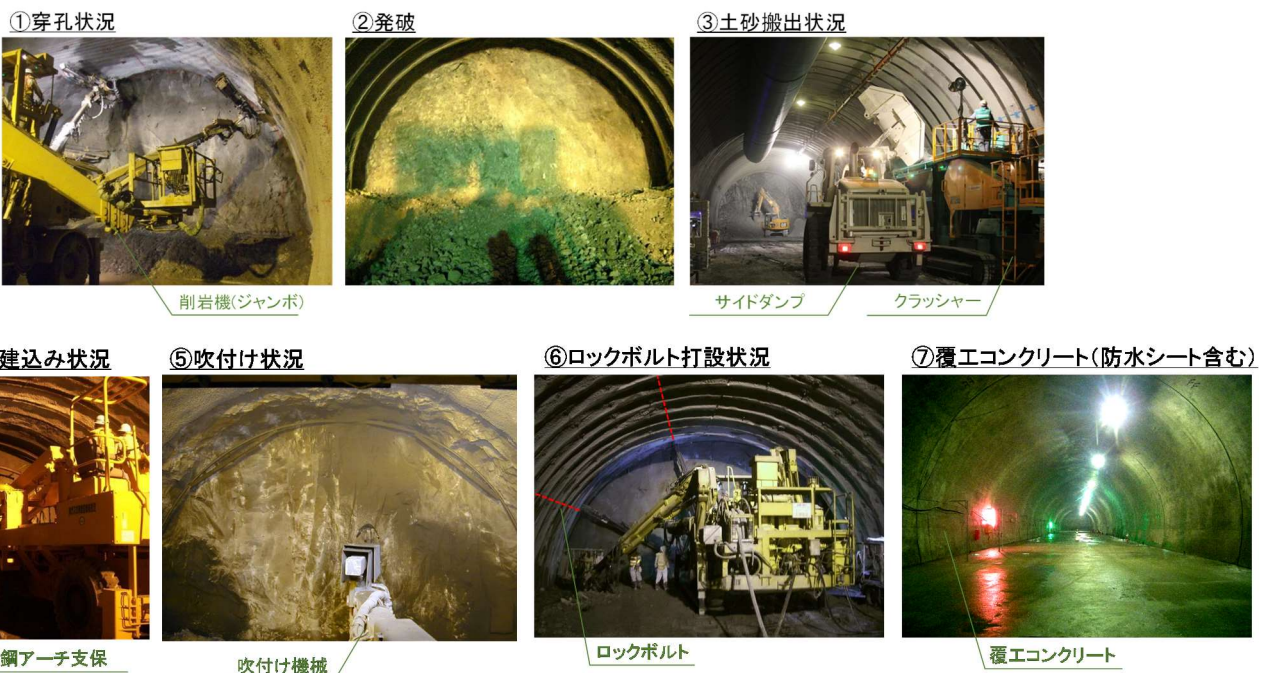
図 9 NATMの標準的な施工手順
