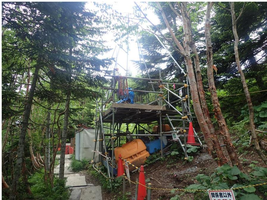
図 24 ボーリング調査実施状況（千枚小屋付近）
