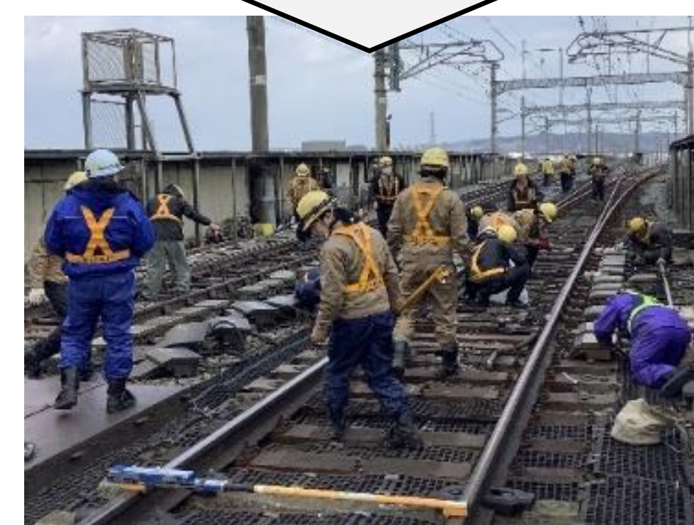
震災復旧工事への活用
