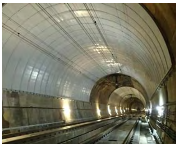
設置完了したFRP内巻工
