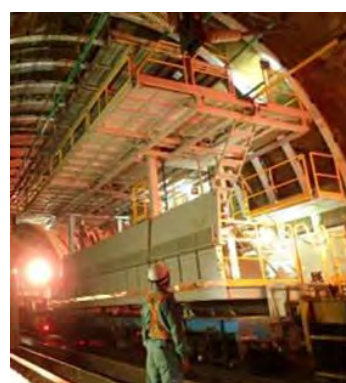
施工用台車による施工
