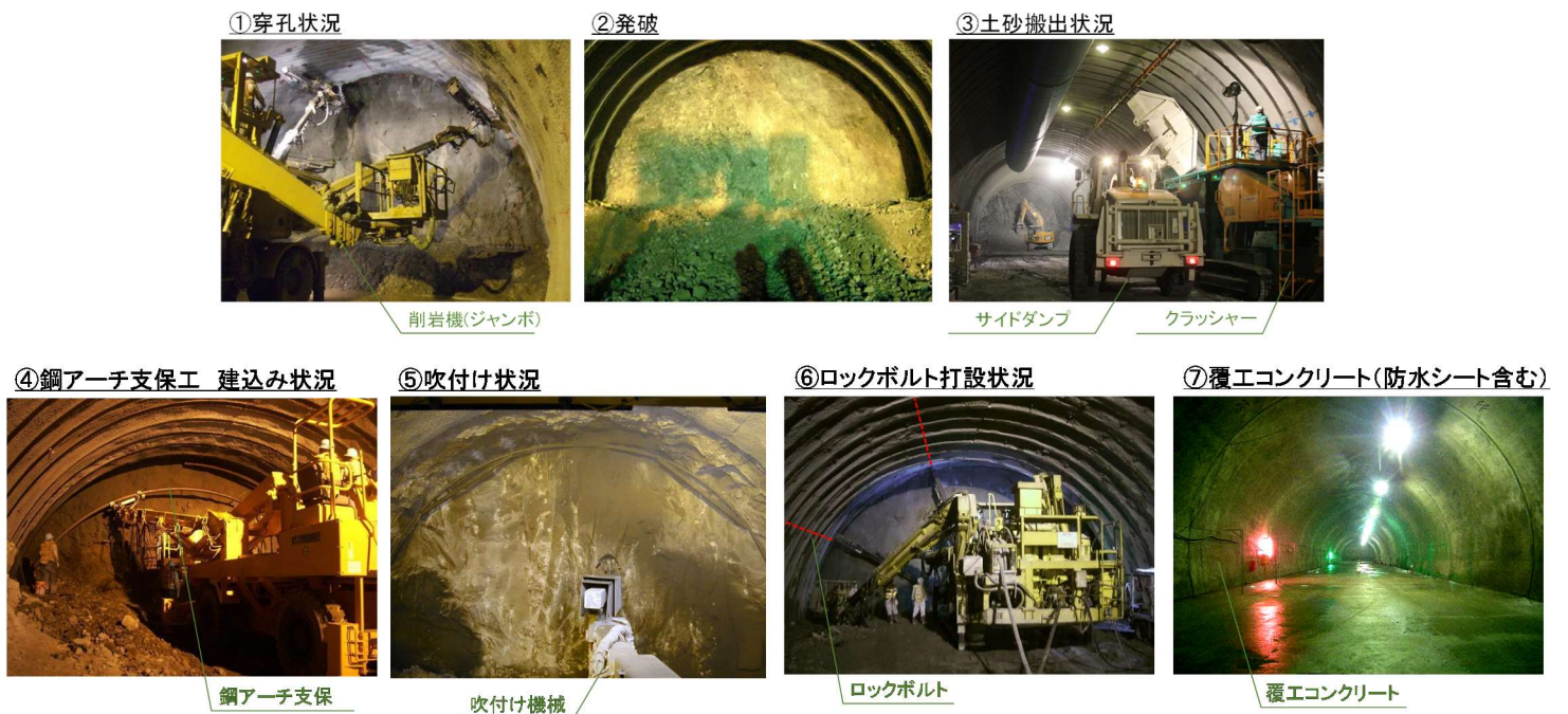
図 9 NATMの標準的な施工手順
