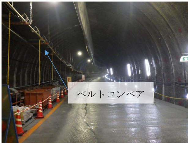
写真 2 ベルトコンベアによる運搬イメージ
