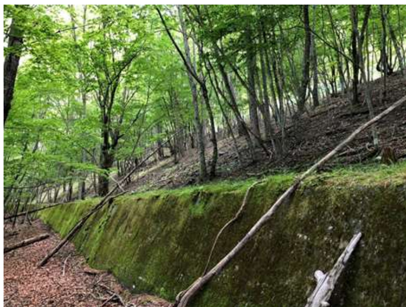
写真2 藤島発生土置き場現地状況
