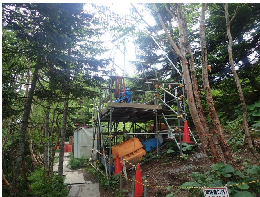
図 36 ボーリング調査実施状況（千枚小屋付近）
