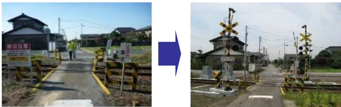
図31: 遮断機・警報機の整備
