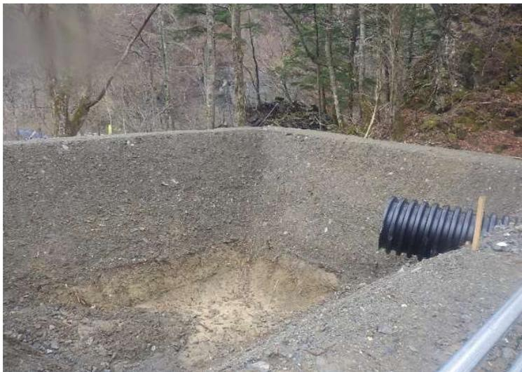
写真 5.1 沈砂池の例
