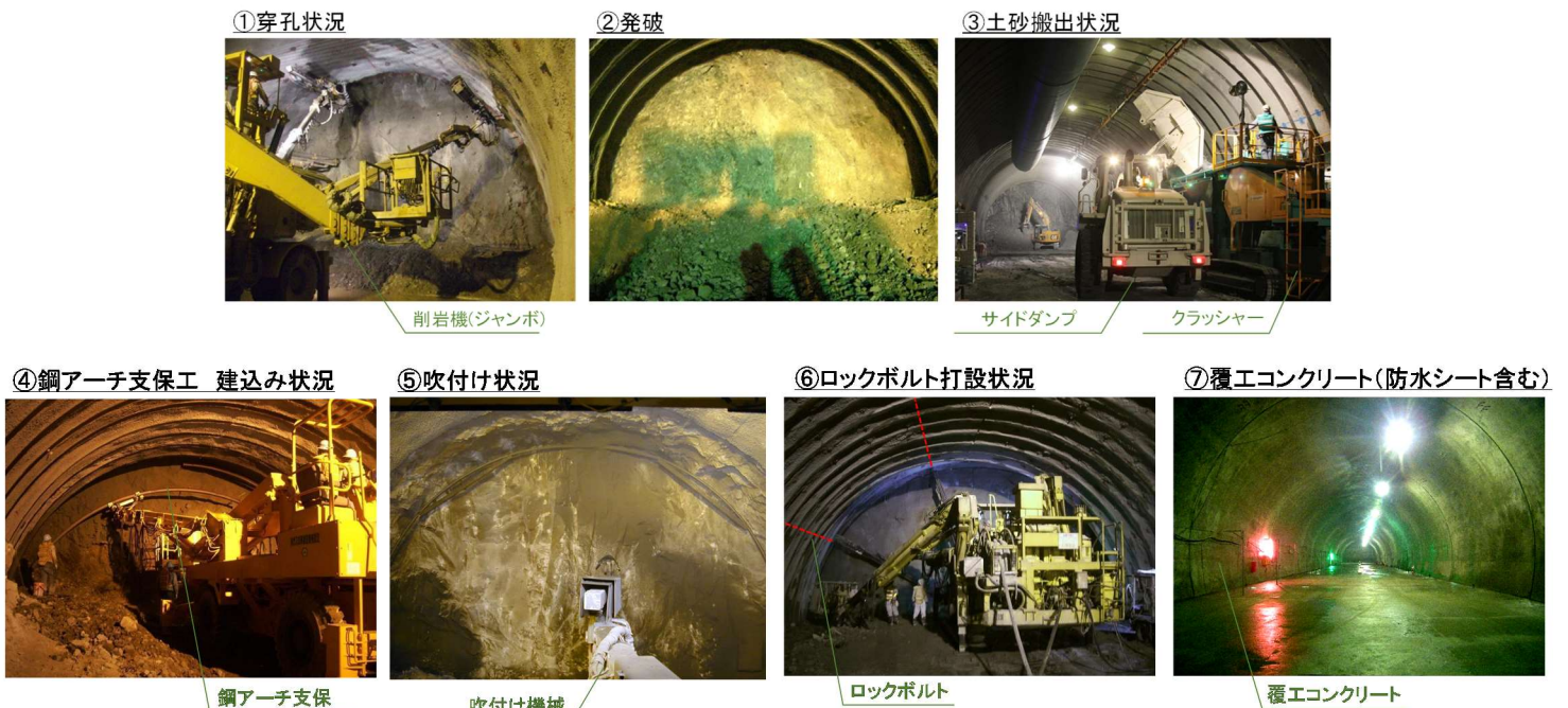
図 1.16 NATMの標準的な施工手順
