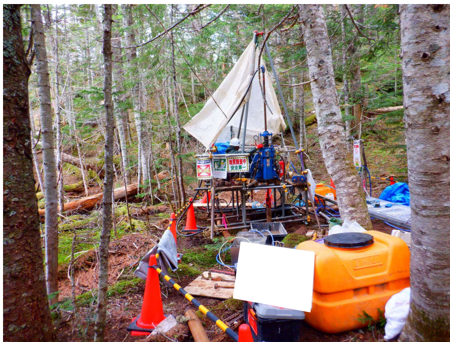
図 4.41 ボーリング調査実施状況（駒鳥池付近）
