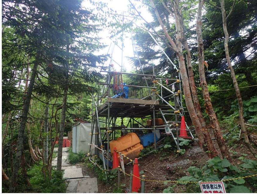
図 4.6 ボーリング調査実施状況（千枚小屋付近）
