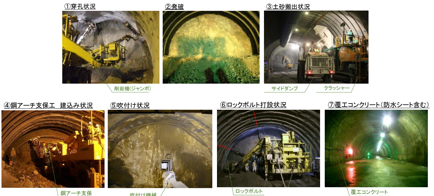
図 1.15 NATMの標準的な施工手順
