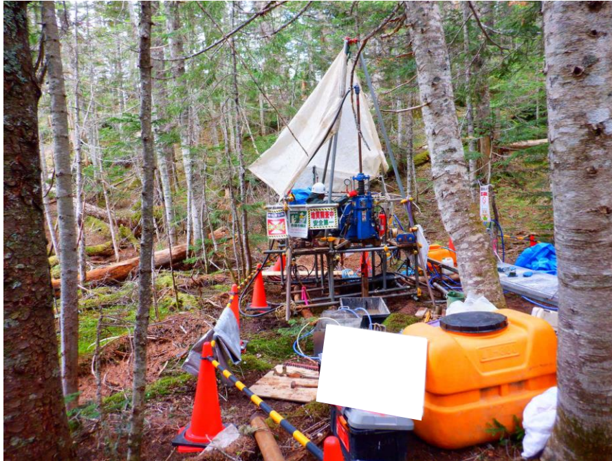
図 4.53 ボーリング調査実施状況（駒鳥池付近）
