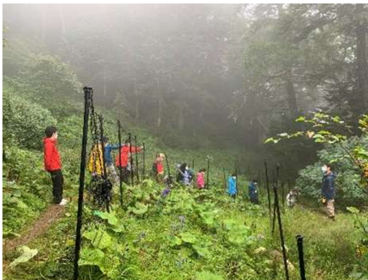
写真 5. 7 獣害防止柵の設置例（千枚小屋付近）
