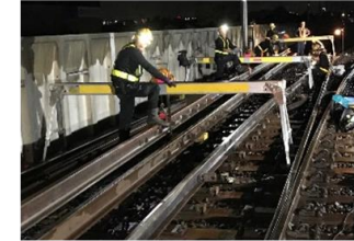
道床碎石の交換工事
