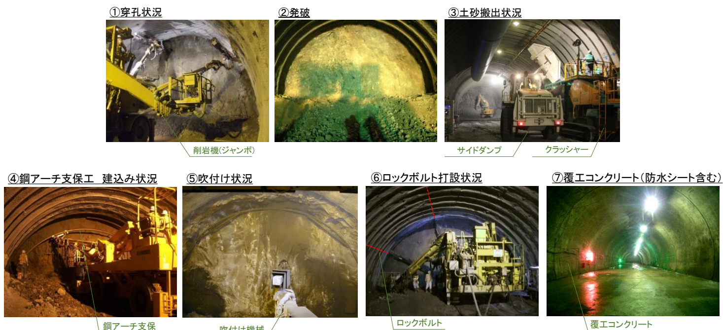
図 1.18 NATMの標準的な施工手順
