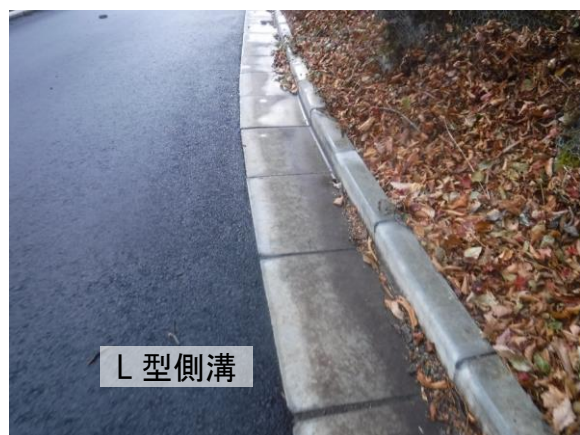
図 1.34 林道東俣線の舗装等工事の実施状況例
