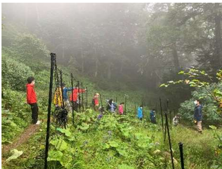
写真 5. 7 獣害防止柵の設置例（千枚小屋付近）
