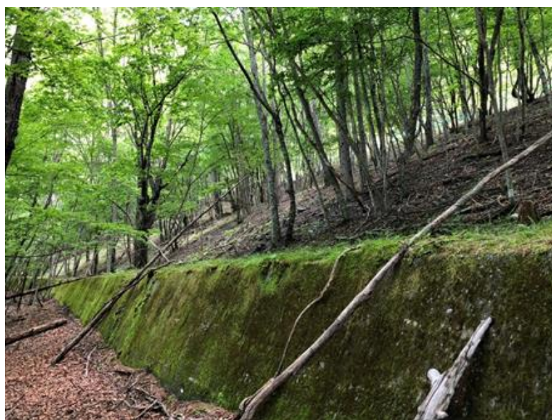
写真1-2 藤島発生土置き場現地状況
