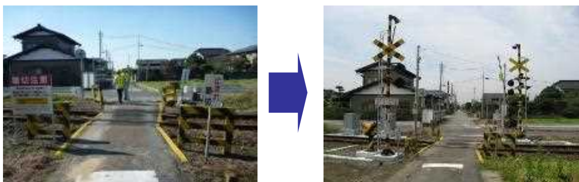
図29：遮断機・警報機の整備
