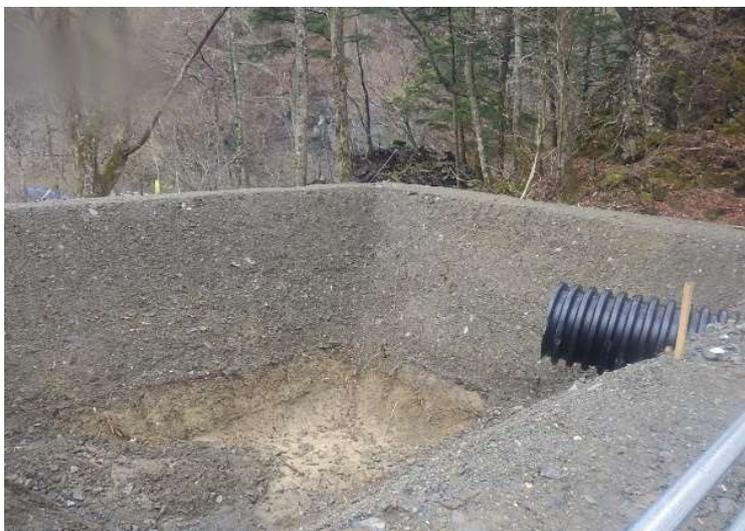
写真 参 1 沈砂池の例
