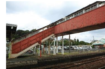
【ホーム上屋・跨線橋等】
