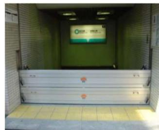
止水板による地下駅の浸水対策
