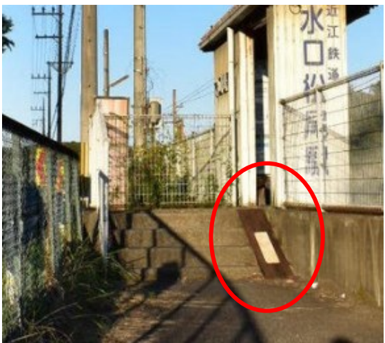
簡易的なスロープを設置する (左：J R 西日本 きのくに線 周参見駅) (右：近江鉄道 水口松尾駅)
