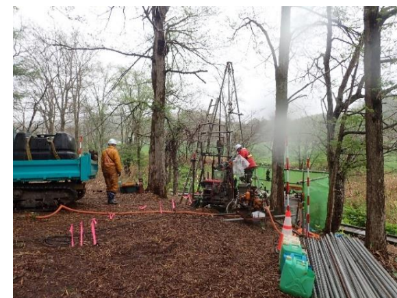
ボーリング調査状況
