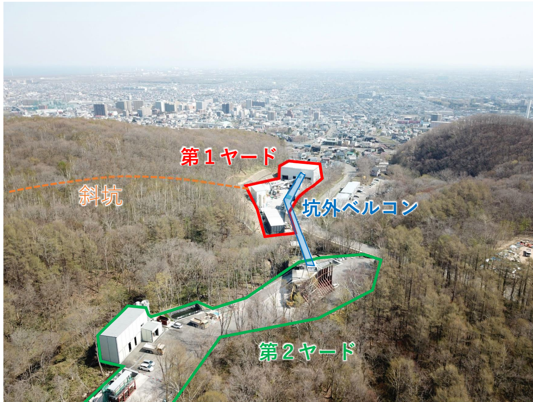
写真 作業ヤード全景 第2ヤードを新たに増設
