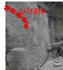
吹付けコンクリートのひび割れ
