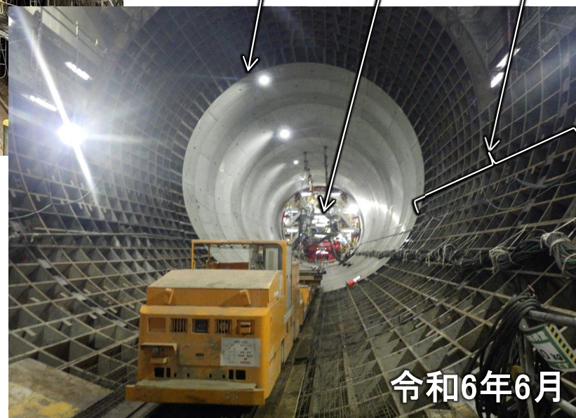
仮組セグメント （後日撤去）
