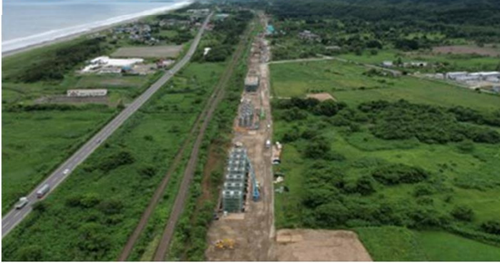
写真⑫ 平里高架橋(長万部町)
