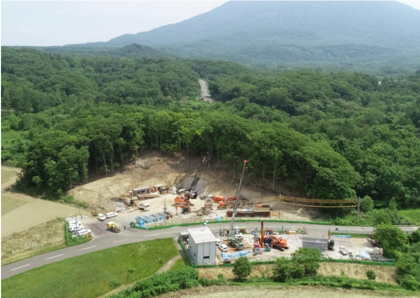
羊蹄トンネル(有島) 岩塊撤去状況
