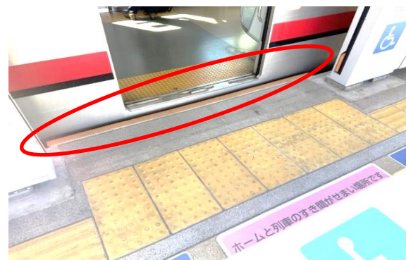
ホームと車両乗降口の段差・隙間の縮小
