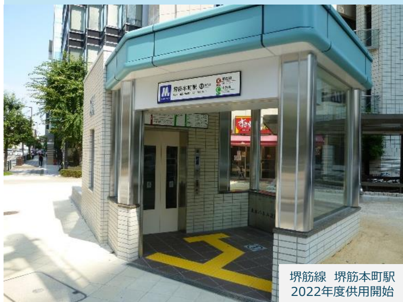
エレベーター
