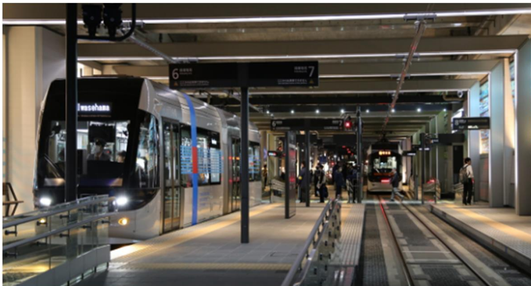
南北接続後のLRT停留所の様子
