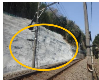
コンクリート法面
