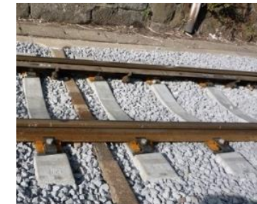
線路設備 (軌道改良(PCマクラギ化))
