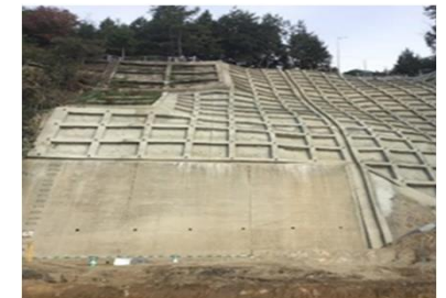
斜面の崩壊防止対策 (コンクリート枠による斜面の補強)
