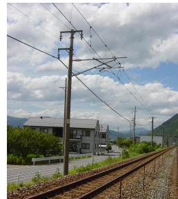
電路設備 (電柱の更新)
