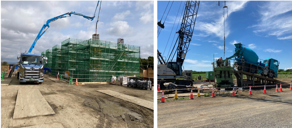
コンクリート打設状況
