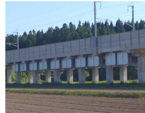
多降雪対応の新しい構造形式の概要図（左）と試験設置状況（右） （開床式高架橋+吊下げ式防音壁）
