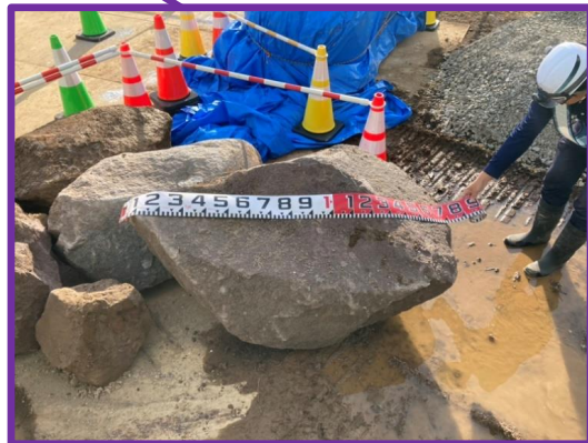
区間A②で撤去した岩塊
