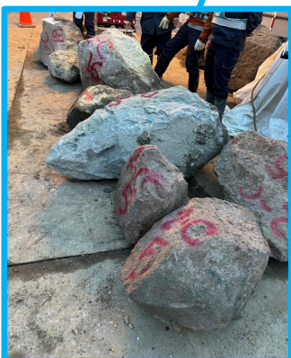
区間A①で撤去した岩塊
