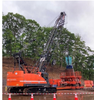
地上からの岩塊撤去状況
