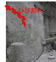
吹付けコンクリートのひび割れ
