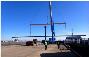
レール陸揚げ状況
