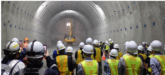
立岩トンネル貫通時の様子 2024（令和6）年7月
