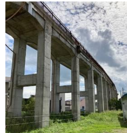
藤城線橋脚 (七飯町)
