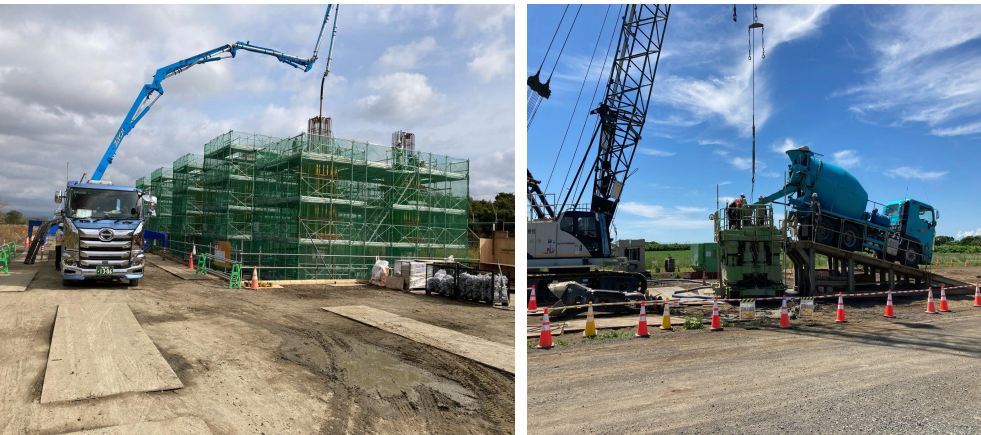
コンクリート打設状況
