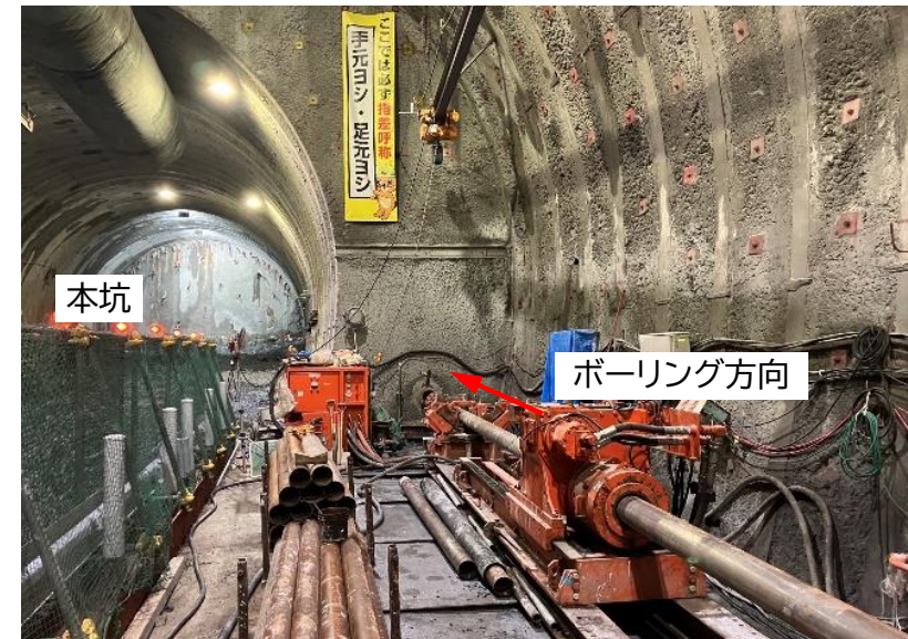
長尺ボーリング削孔状況
