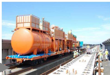
D : CAモルタル注入
