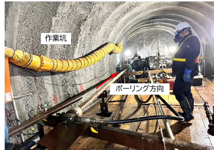
長尺ボーリング削孔状況
