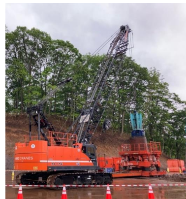
地上からの岩塊撤去状況
