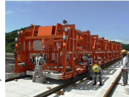
D : 軌道スラブ敷設
