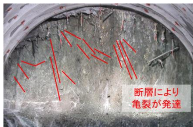
【特徴1】断層運動に伴う弱部の形成
