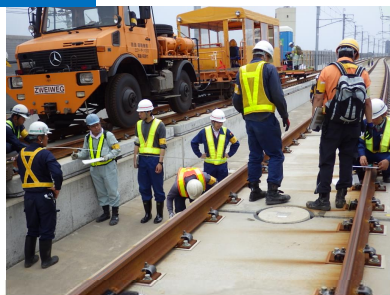
軌道の仕上がり状態等の確認
