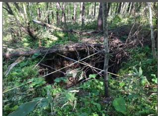
地表面陥没状況
