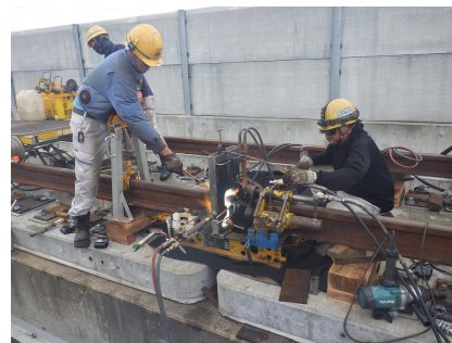
E : 二次溶接
