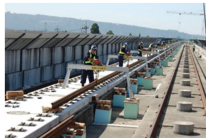
D : レール敷設
