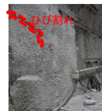
吹付けコンクリートのひび割れ
