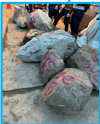
区間A①で撤去した岩塊
