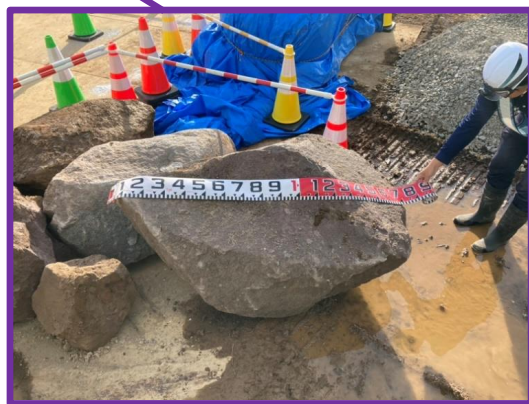
区間A②で撤去した岩塊
