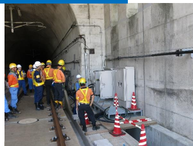
電気設備の外観検査及び機能確認試験
