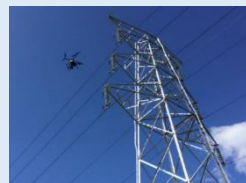
ドローンを活用した送電線検査
