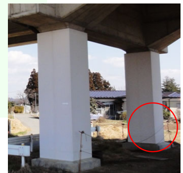
鋼板巻き補強
