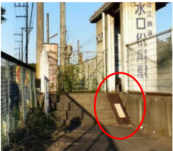
簡易的なスロープを設置する (左：J R西日本 きのくに線 周参見駅) (右：近江鉄道 水口松尾駅)
