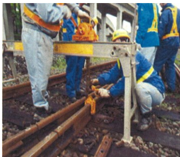
軌道整備イメージ (レール交換作業)
