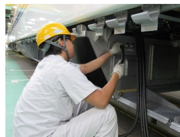
車両製造イメージ (配線配管作業)
