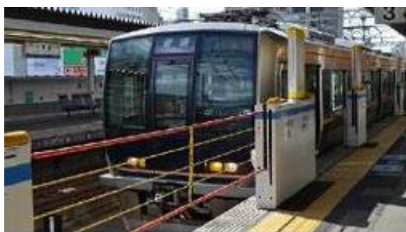
昇降ロープ式ホーム柵
