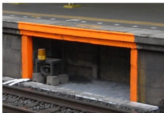
ホーム下の待避スペース
