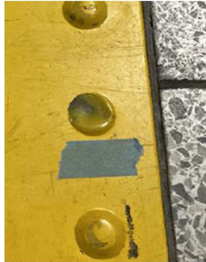
修繕前の状況
