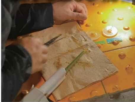
施工時の様子
