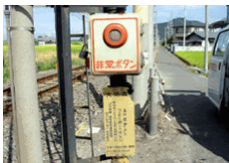
踏切支障押しボタン
