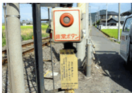
踏切支障押しボタン
