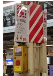
図3:非常停止押しボタン
