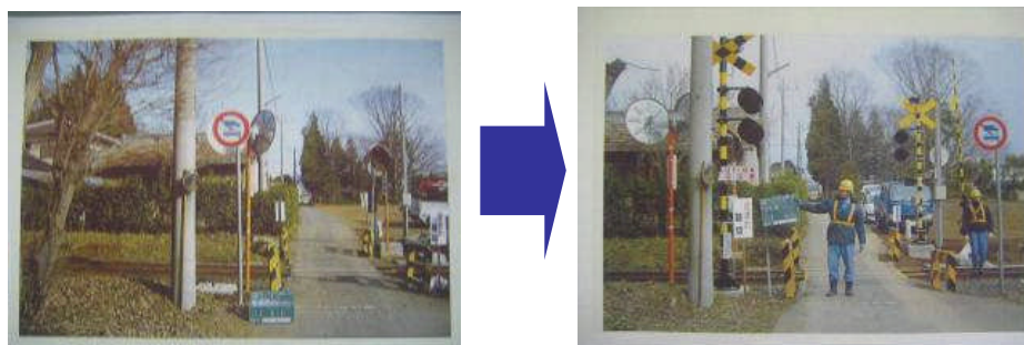
図1:踏切遮断機・警報機の整備
