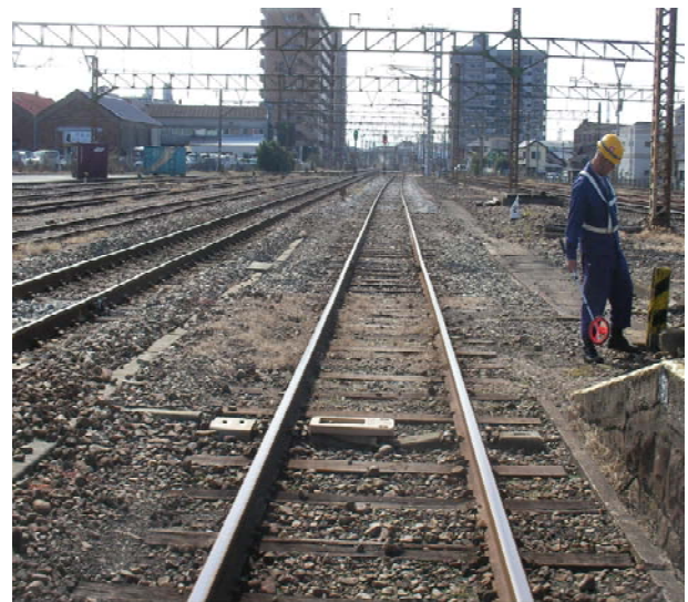
2番線ホーム端付近からの見通し
