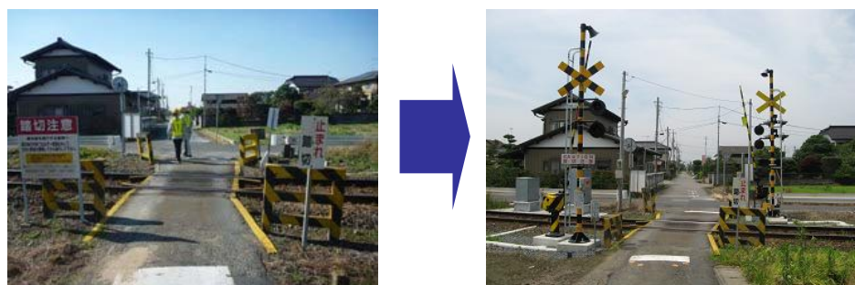
図1：踏切遮断機・警報機の整備
