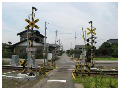
図18:踏切遮断機・警報機の整備
