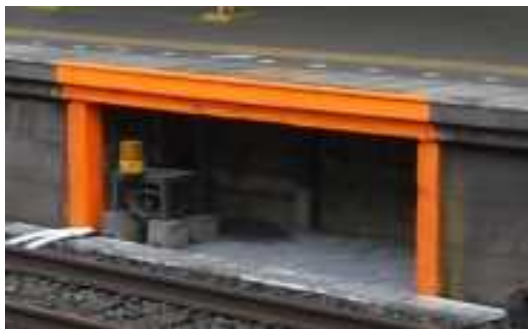
ホーム下の待避スペース
