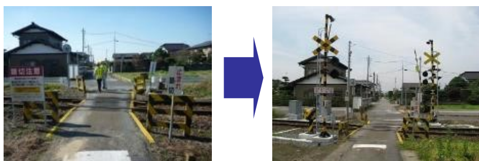
図21：踏切遮断機・警報機の整備
