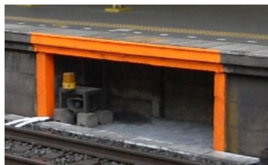
ホーム下の待避スペース
