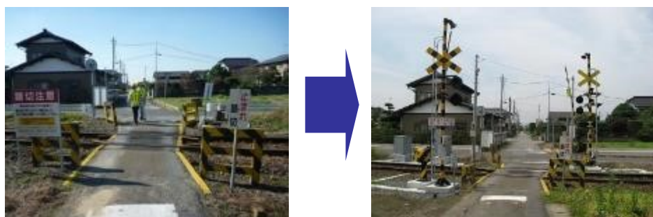
図25：遮断機・警報機の整備
