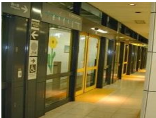
図1：ホームの安全対策設備例
